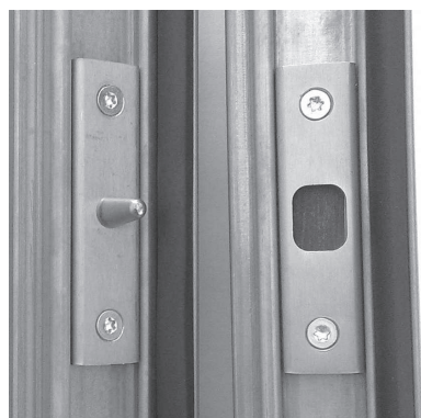
Anbringen der Sicherungselemente
