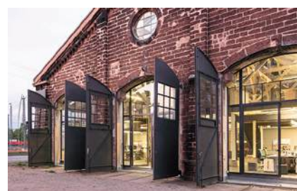
22 Lokschuppen, Mannheim/DE A B
