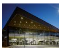
60 Vogtlandhalle (Stadthalle), Greiz/DE
