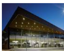
60 Vogtlandhalle (Stadthalle), Greiz/DE
