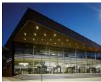
60 Vogtlandhalle (Stadthalle), Greiz/DE
