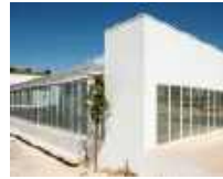
5 Hauptschule Lima de Freitas, Setubal/PT
